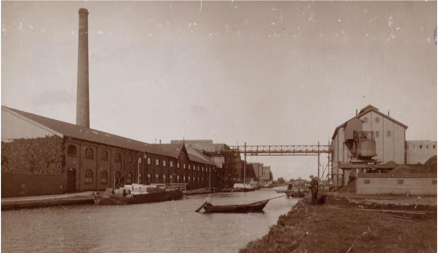
De situatie rond 1915. De schoorsteen is nog niet omgebouwd tot watertoren en het nieuwe ketelhuis is d.m.v. een pijpenbrug over de Westerveersloot verbonden met de fabriek. Rechts is, voor het nieuwe ketelhuis, het kolenpark met de loskraan.
