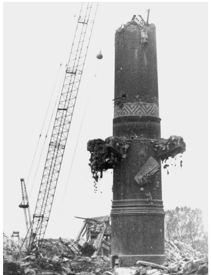
De sloop van de watertoren in 1983. Let vooral op de fraaie detaillering van het metselwerk in de vroegere fabrieksschoorsteen.
